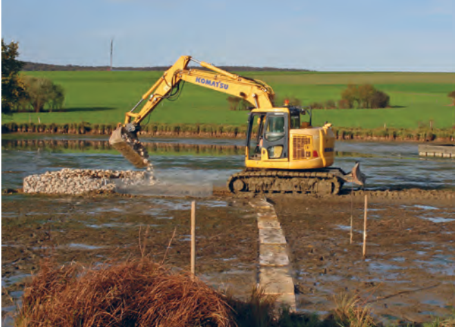
Fig. 9. Aménagement d'un îlot de gravier, 27.10.22
