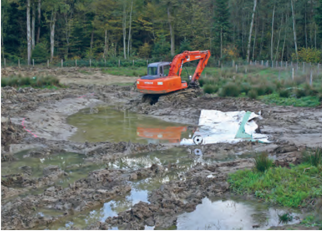
Fig. 7. Travaux d'étanchéification, Lugnez, 27.10.22
